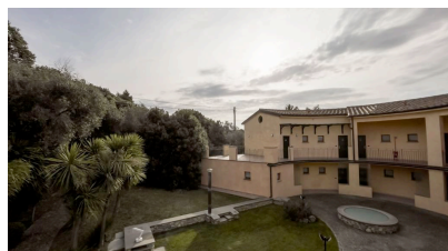
1 vista fotografica attuale dal giardino interno
