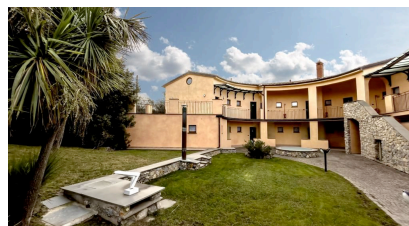
2 vista fotografica attuale dal giardino interno
